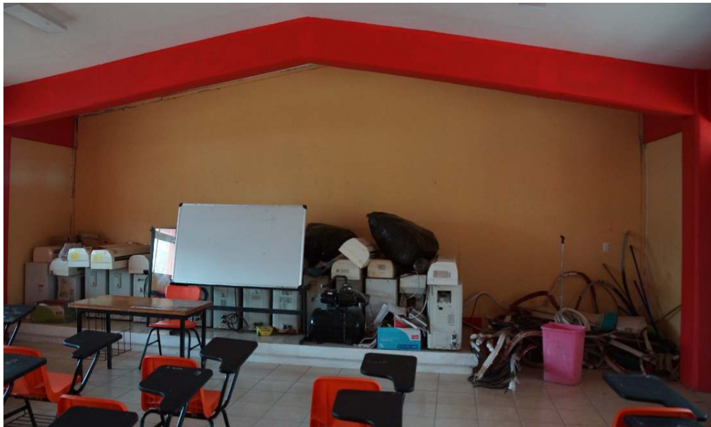
Edificio de concreto U1C, diseño 1990
