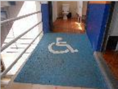
Rampa para personas con discapacidad
