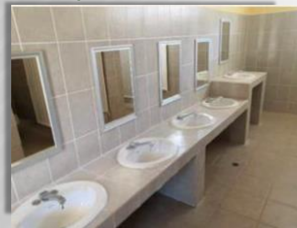
Interior de sanitarios
