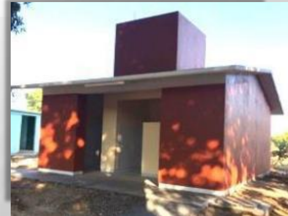
Módulo de sanitarios
