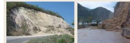
Figura 10.16 Ejemplos de deslizamientos de taludes artificiales. Fuente: cortesía de José Luis Rangell (2020).
