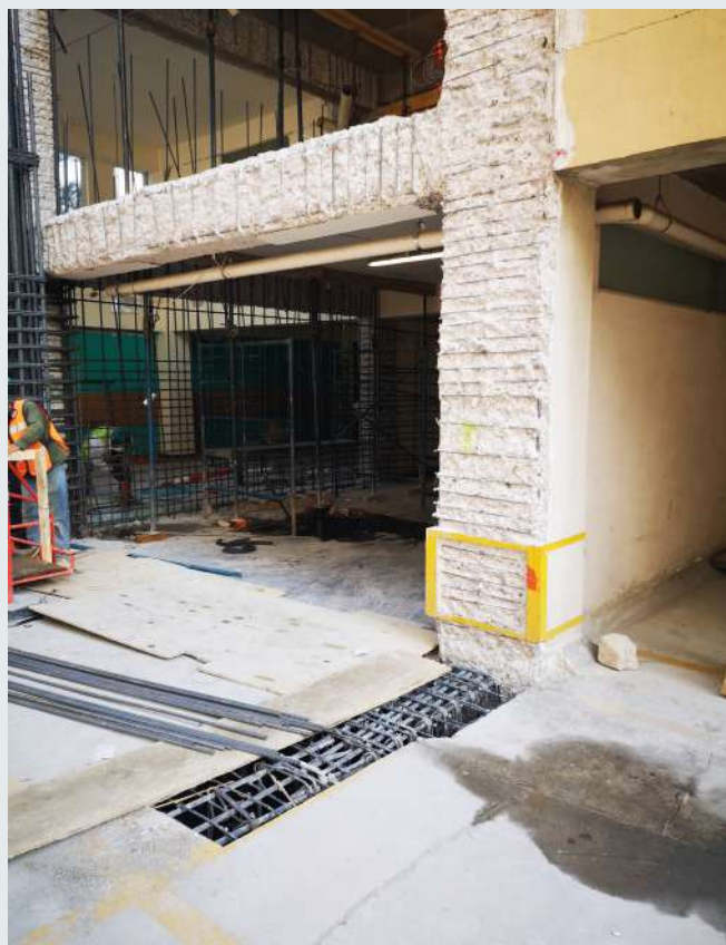
Figura 6.10.18 Figura 6.10.18 Preparación de la superficie del concreto existente que estará en contacto con el nuevo concreto con rugosidad media de 6 mm (1/4 pulg). Fuente: archivo personal de Rubén Bautista (2019).
