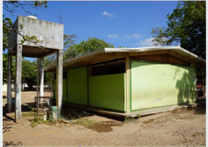
Figura 1.6.5 Concentración de masa en techos de edificios escolares y depósito de agua en una estructura independiente. Fuente: cortesía del INIFED (2019b).
