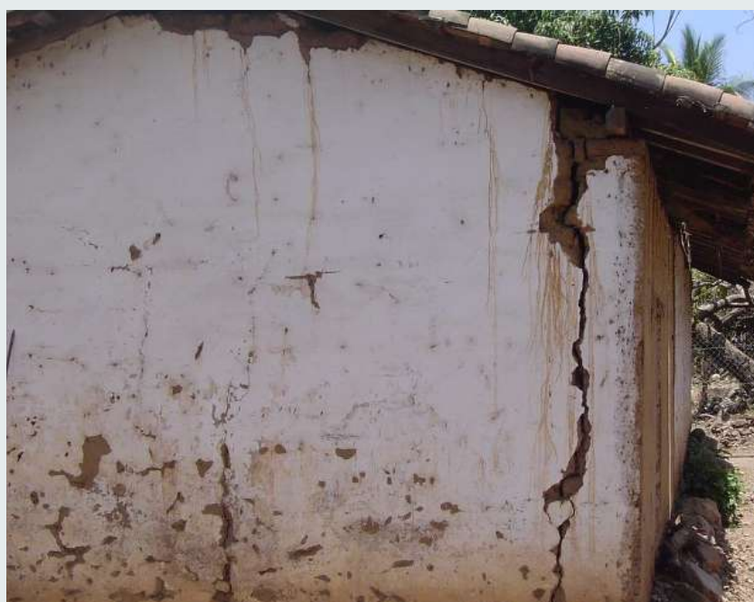
Figura 1.6.19 Agrietamiento vertical en la intersección de muros de mampostería simple (adobe). Fuentes: cortesía del INIFED (2019b) y archivo personal de Sergio Alcocer (1995).
