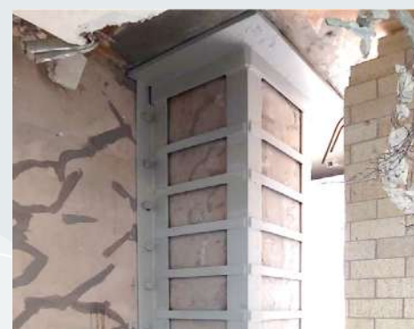
Figura 6.7.8 Ejemplos de la colocación de placas de acero en los extremos de la columna para conectar el encamisado a la columna y también a la losa. Fuente: cortesía del INIFED (2019b).
