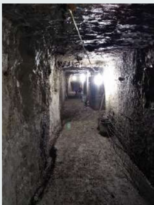
Trincheras de subexcavación
