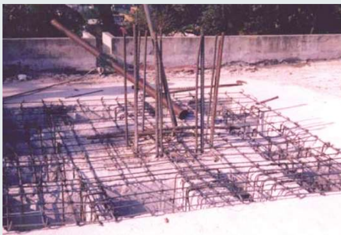
Figura 6.2.5 Reforzamiento de una losa plana mediante la construcción de una zona maciza alrededor de las columnas. Fuente: cortesía de Jorge Aguilar (2020).
