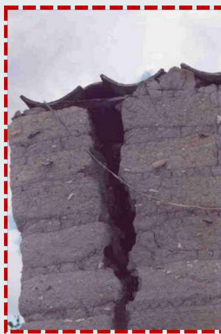
Figura 1.6.19 Agrietamiento vertical en la intersección de muros de mampostería simple (adobe). Fuentes: cortesía del INIFED (2019b) y archivo personal de Sergio Alcocer (1995).
