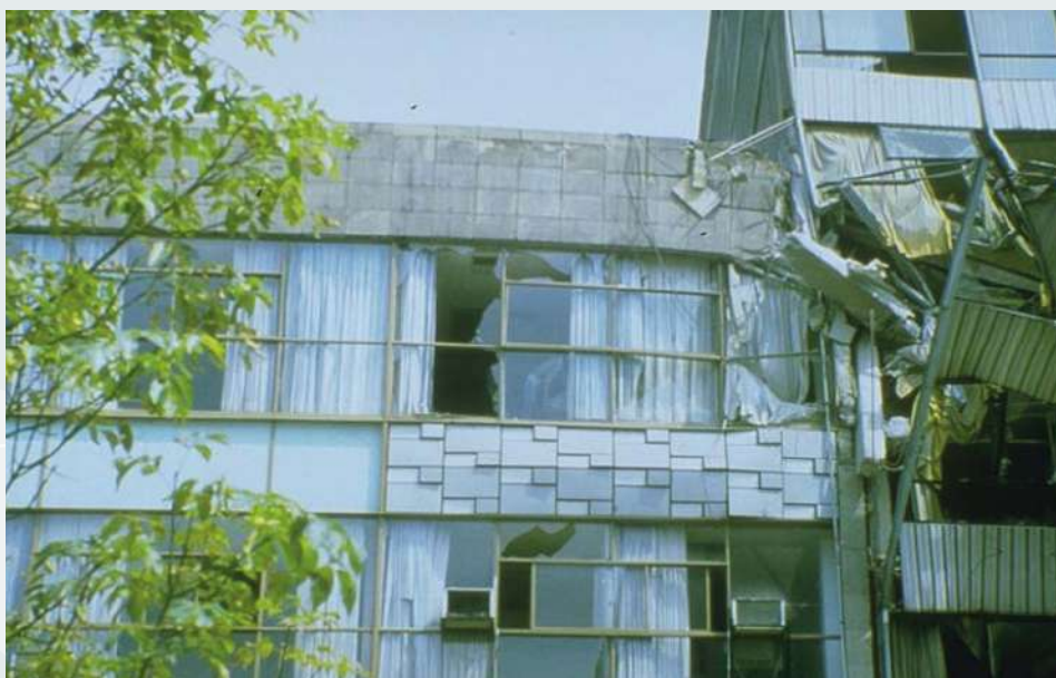
Figura 4.2.4 Golpeteo de edificios. Fuente: archivo personal de Sergio Alcocer (1985).
