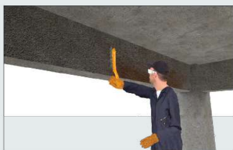
a) Preparación de la superficie
