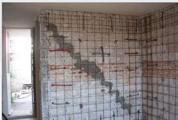
Figura 6.9.2 Práctica correcta: continuidad del refuerzo del encasado en muros transversales mediante traslape de malla en forma de letra L. Fuente: archivo personal de Sergio Alcocer (2003).
