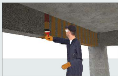
c) Aplicación de la resina saturante
