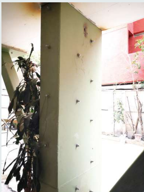
Figura 6.7.15 Distribución adecuada de conectores en encamisado de placas de acero. Fuente: archivo personal de Rubén Bautista (2019).
