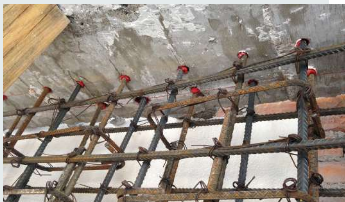
Figura 6.5.7 Barras corrugadas de acero colocadas dentro de un agujero con resina epóxica. Fuente: archivo personal de Rubén Bautista (2019).
