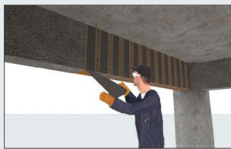
d) Colocación de la fibra
