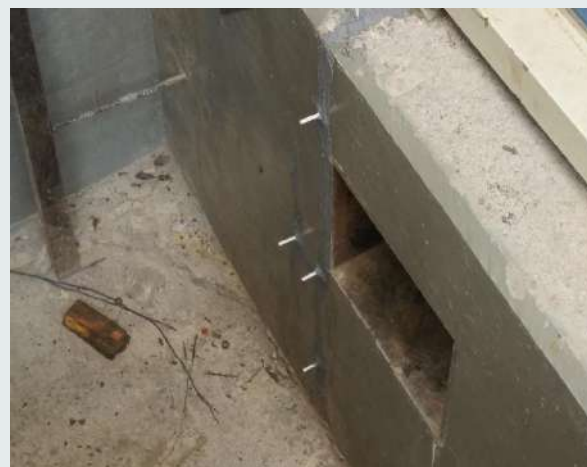
b) Colocación de boquillas para inyección
