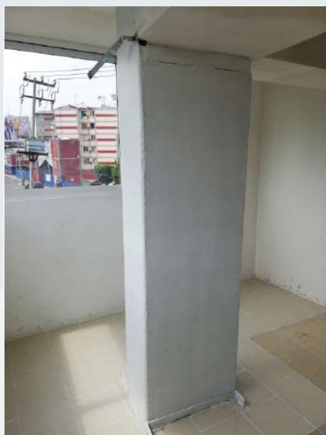
a) Columna con encamisado completo sin conectores
