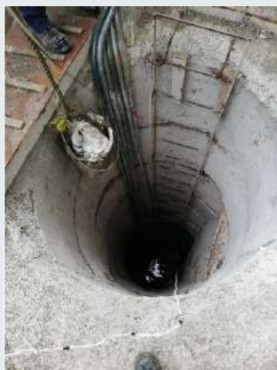
Lumbreras de subexcavación
