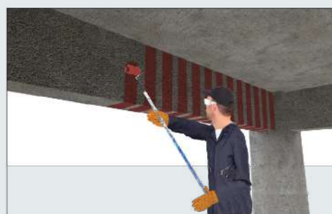
b) Aplicación de la imprimación
