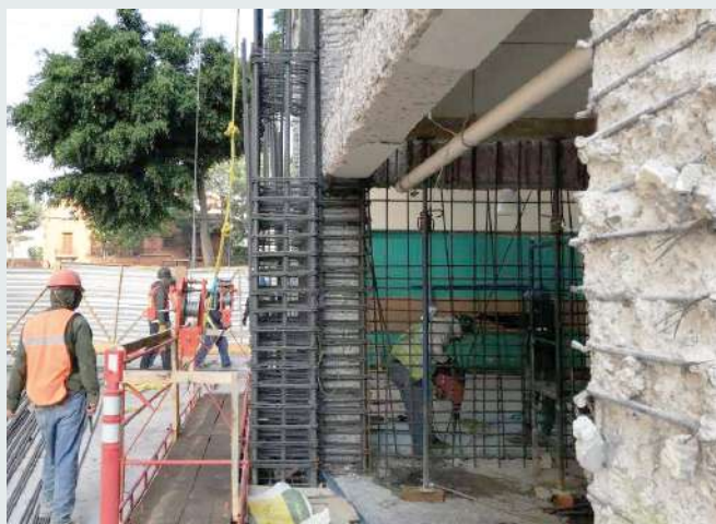
Figura 6.10.17 Muros excéntricos conectados a la estructura original por medio de encamisados de columnas. Fuente: archivo personal de Bernardo Moctezuma (2019).
