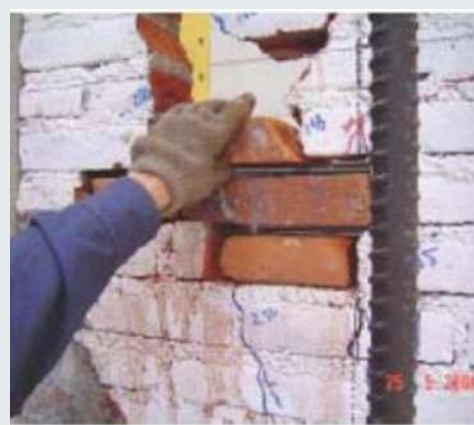
Figura 6.9.9 Reemplazo de piezas aplastadas. Fuente: Flores et al. (2004).
