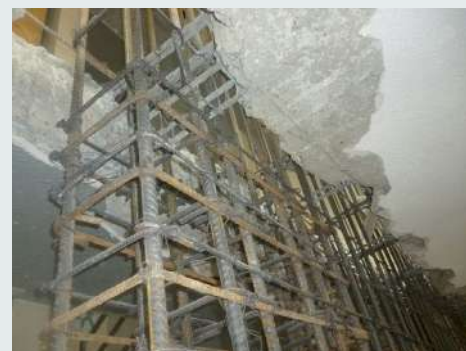
b) Anclas ahogadas en el sistema de piso inferior para ser traslapadas con las barras de refuerzo vertical del nuevo muro
