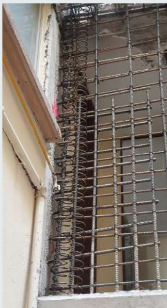
Figura 6.10.5 Refuerzo helicoidal vertical para confinar traslapes en muros. Fuente: archivo personal de Rubén Bautista (2019).
