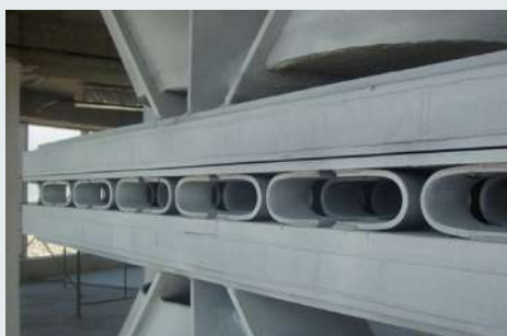
d) Disipadores histeréticos de placa tipo oruga
