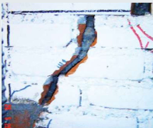
Figura 6.9.7 Reparación de grietas mediante relleno con mortero. Fuente: Flores et al. (2004).
