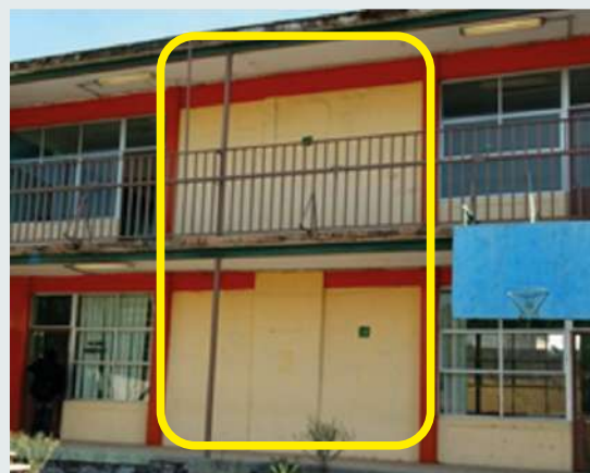
Figura 6.10.21 Escuela rehabilitada con muros de concreto reforzado. Fuente: cortesía del INIFED (2019b).
