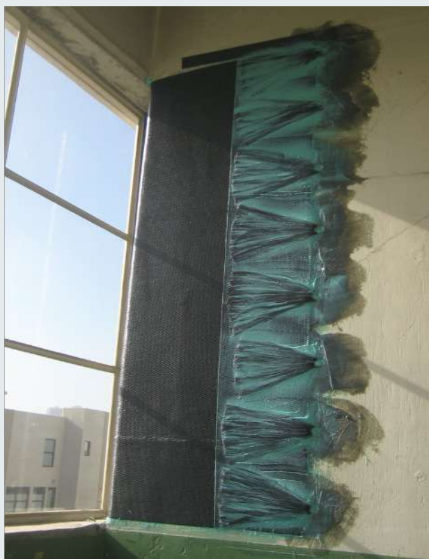
b) Conectores de CPRF para anclar las fibras
