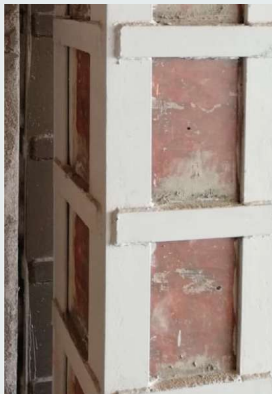
Figura 6.7.16 Mortero fluido sin contracción colocado entre las soleras y el concreto. Fuente: archivo personal de Víctor Cruz (2019).
