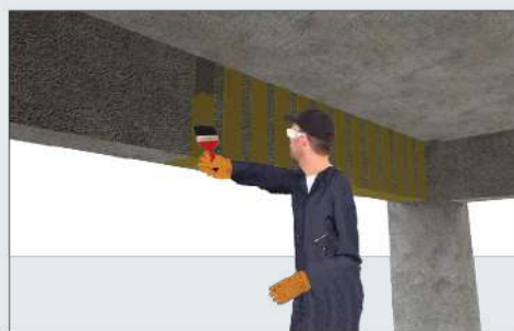
e) Aplicación de la segunda capa de la resina saturante
