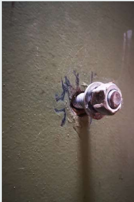
Figura 5.6.1 Tipos de anclas y conectores post-instalados. Fuente: elaboración propia con base en ACI 355.3R, 2011 y archivo personal de Rubén Bautista (2018).
