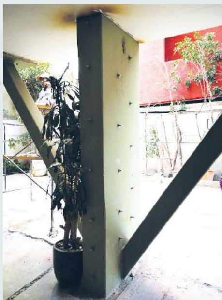
b) Columna con encamisado completo con conectores
