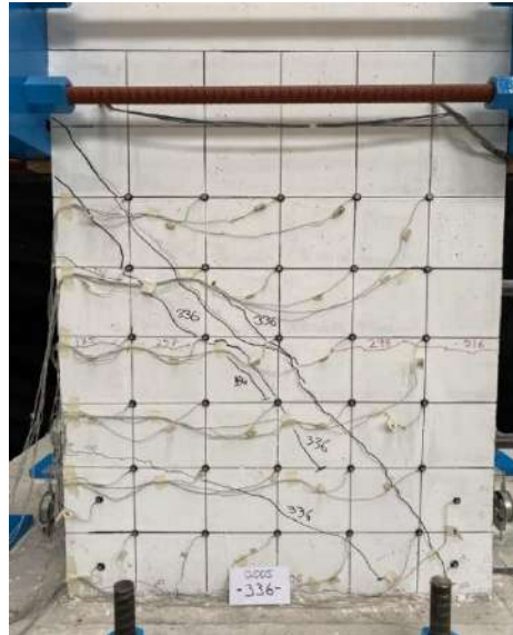
Fig. 3.3.2 Columna O (R=0.5%) (Instituto de Ingeniería, 2021 - 2023)
