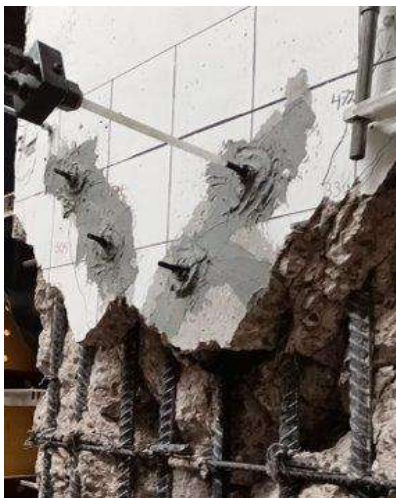
Fig. 3.3.27 Inyección de grietas - Columna OR (Instituto de Ingeniería, 2021 - 2023)
