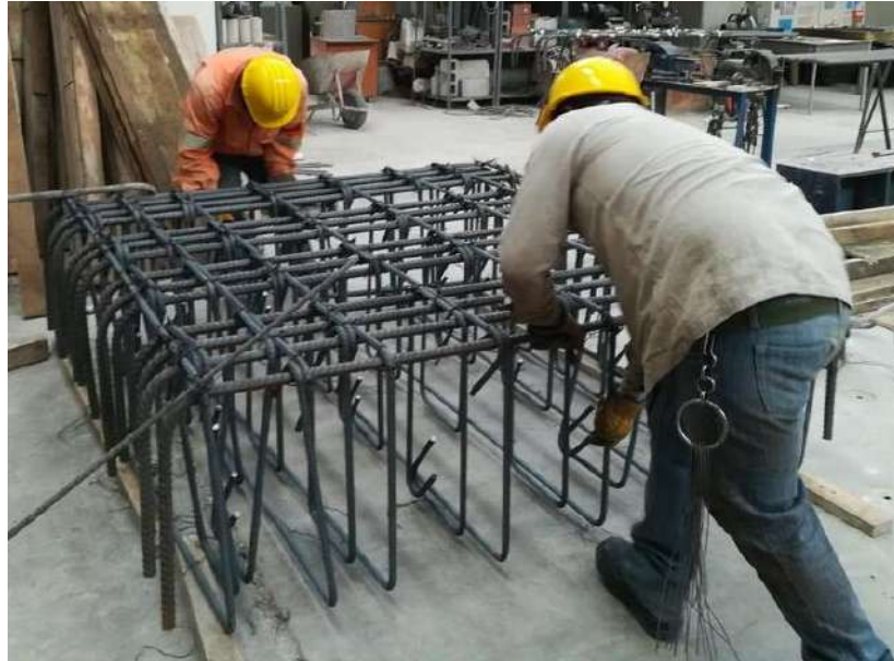
Fig. 2.5.10 Armado de la zapata (Instituto de Ingeniería, 2021 - 2023)
