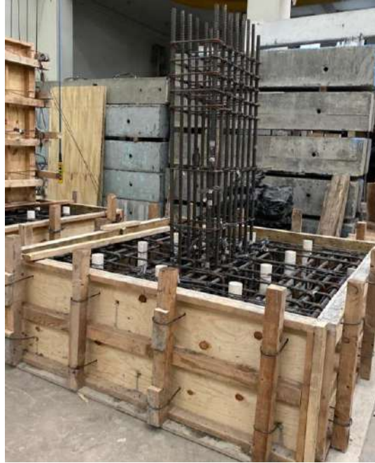
Fig. 2.5.14 Cajón de cimbra de la zapata (Palma, 2022 - 2023)
