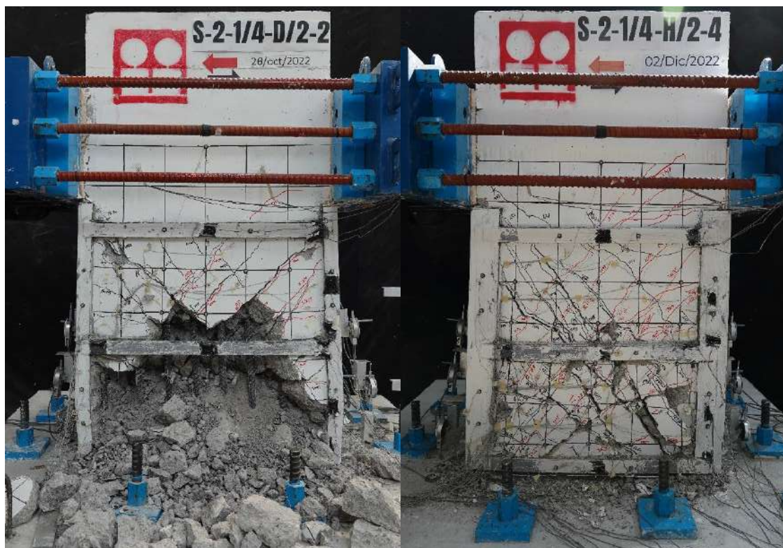
Fig. 6.1.3 Comparación del estado final del daño
