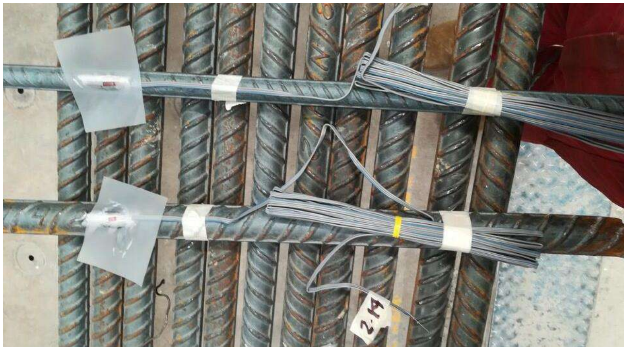
Fig. 2.5.6 Cables de deformímetros (Instituto de Ingeniería, 2021 - 2023)
