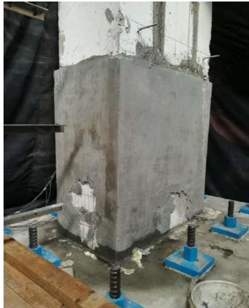
Fig. 3.3.31 Resultado de la rehabilitación - Columna OR (Instituto de Ingeniería, 2021 - 2023)
