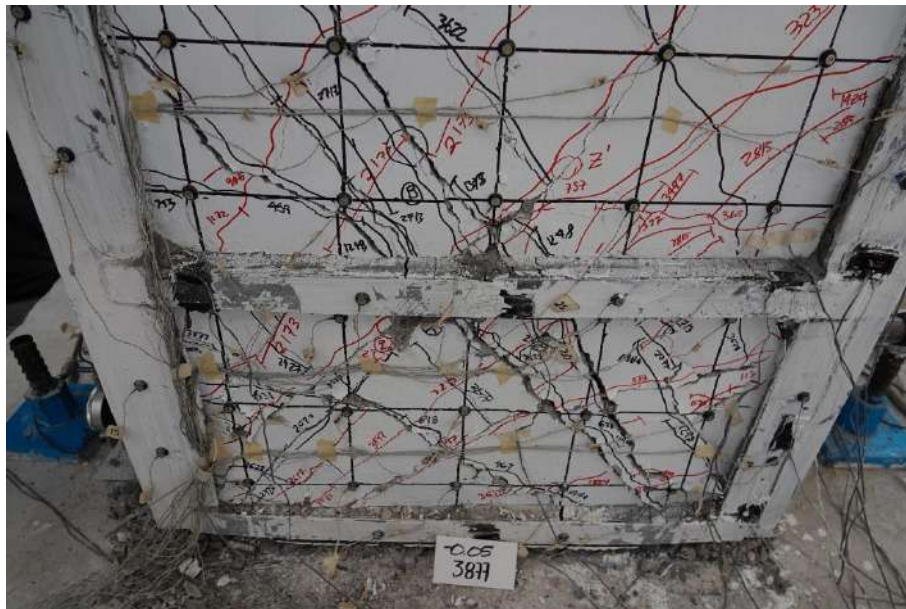
Fig. 3.3.203 Estado del grout ( R=-5\% ) - Columna C-4 (Instituto de Ingeniería, 2021 - 2023)
