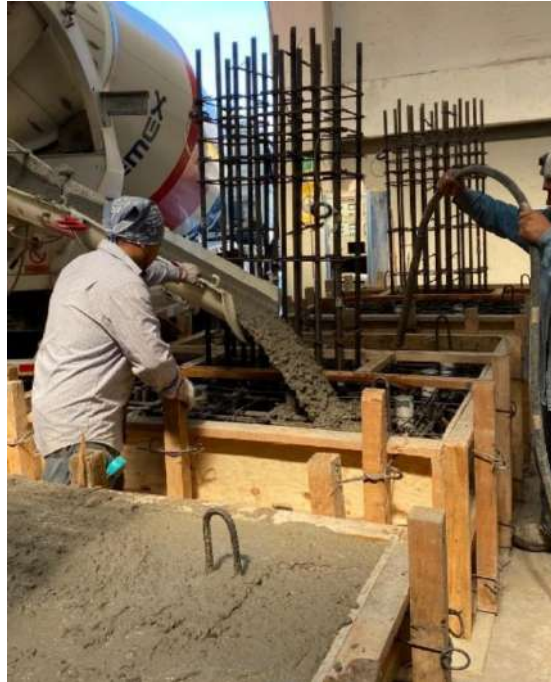
Fig. 2.5.16 Colado del concreto en las zapatas (Palma, 2022 - 2023)
