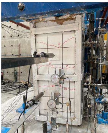
Fig. 3.3.116 Primeras grietas en la cara oeste - Columna C-2 (Instituto de Ingeniería, 2021 - 2023)
