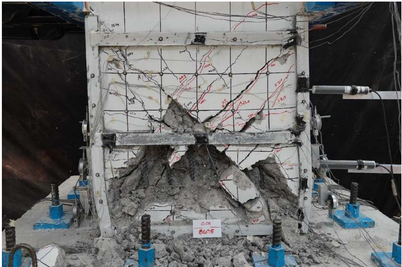
Fig. 3.3.161 Cara norte (R=5%) - Columna C-2 (Instituto de Ingeniería, 2021 - 2023)
