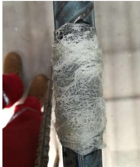
Fig. 2.5.8 Barra envuelta en gasa y con resina aplicada (Instituto de Ingeniería, 2021 - 2023)
