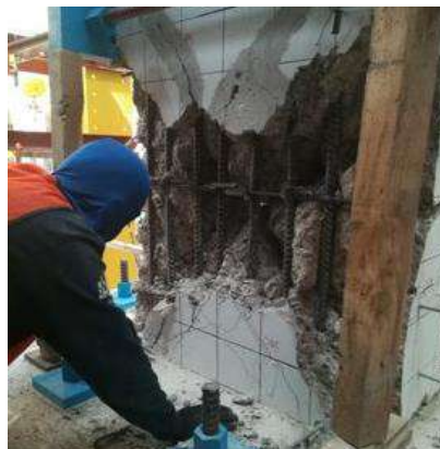
Fig. 3.3.25 Inicio del procedimiento de rehabilitación - Columna OR (Instituto de Ingeniería, 2021 - 2023)
