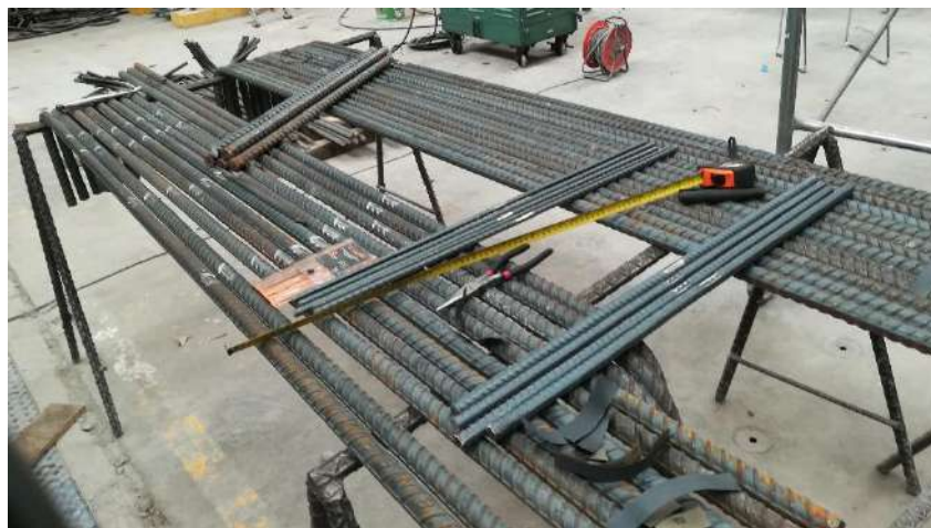
Fig. 2.5.1 Barras de acero sobre caballetes metálicos (Instituto de Ingeniería, 2021 - 2023)
