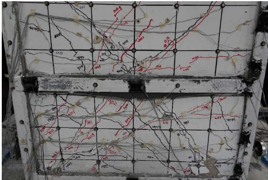
Fig. 3.3.133 Desprendimiento de grout cara norte - Columna C-2 (Instituto de Ingeniería, 2021 - 2023)
