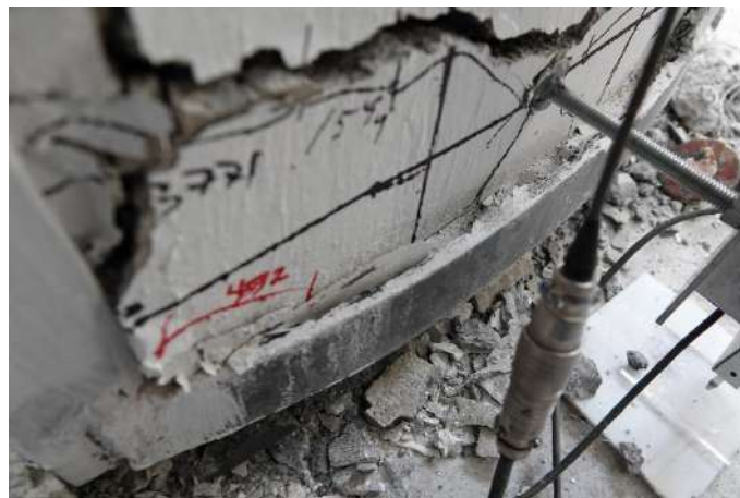
Fig. 3.3.160 Flexión fuera de plano de solera en cara este - Columna C-2 (Instituto de Ingeniería, 2021 - 2023)
