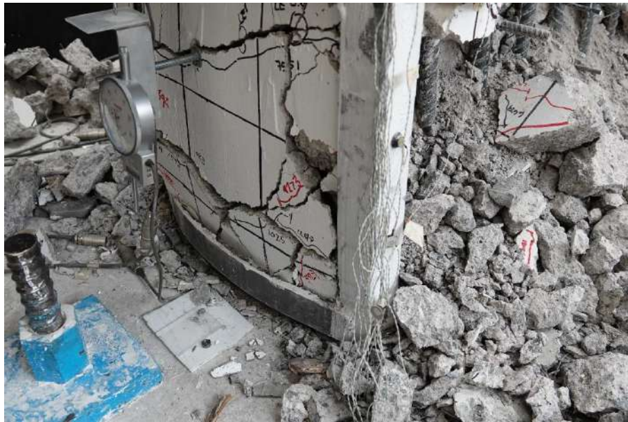
Fig. 3.3.172 Estado final del daño, deformación de solera - Columna C-2 (Instituto de Ingeniería, 2021 - 2023)
