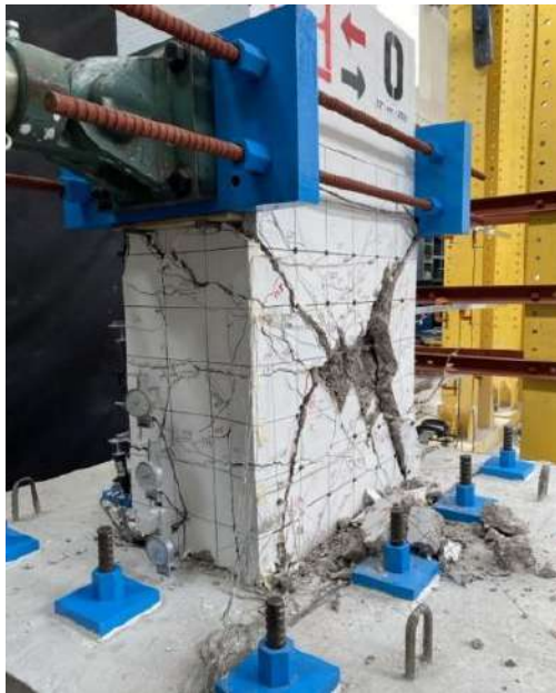
Fig. 3.3.16 Estado final del daño Columna O cara este (Instituto de Ingeniería, 2021 - 2023)
