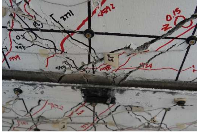
Fig. 3.3.139 Grout en cara norte - Columna C-2 (Instituto de Ingeniería, 2021 - 2023)
