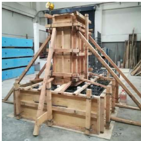
Fig. 2.5.15 Cimbra de la columna (Instituto de Ingeniería, 2021 - 2023)
