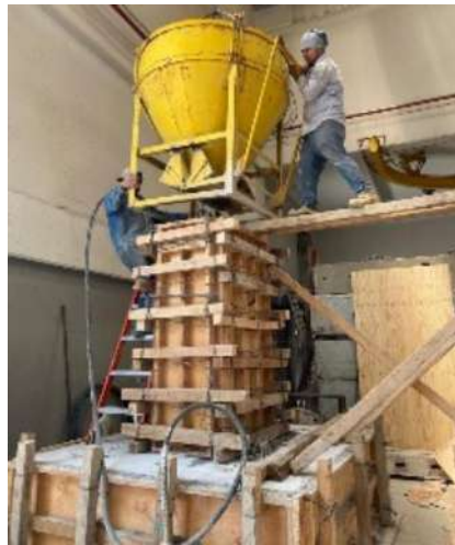
Fig. 2.5.18 Colado de las columnas (Palma, 2022 - 2023)
