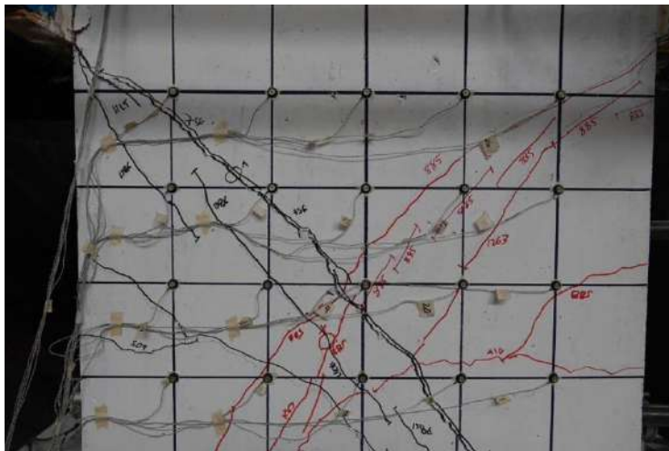
Fig. 3.3.76 Aparición y extensión de grietas ( R=-1\% ) - Columna O* (Instituto de Ingeniería, 2021 - 2023)
