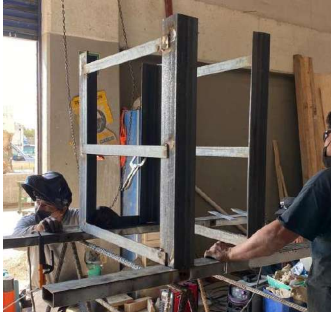
Fig. 2.5.22 Proceso constructivo del encamisado metálico (Palma, 2022 - 2023)
