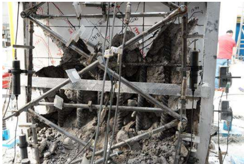
Fig. 3.3.174 Estado final del daño cara sur - Columna C-2 (Instituto de Ingeniería, 2021 - 2023)
