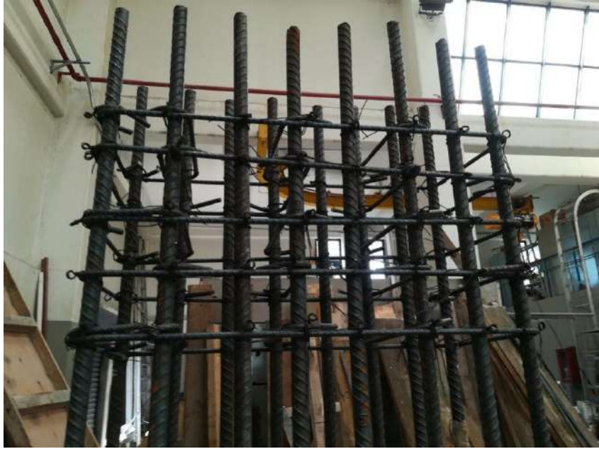
Fig. 2.5.11 Detalle de los estribos en el armado de la columna (Palma, 2022 - 2023)
