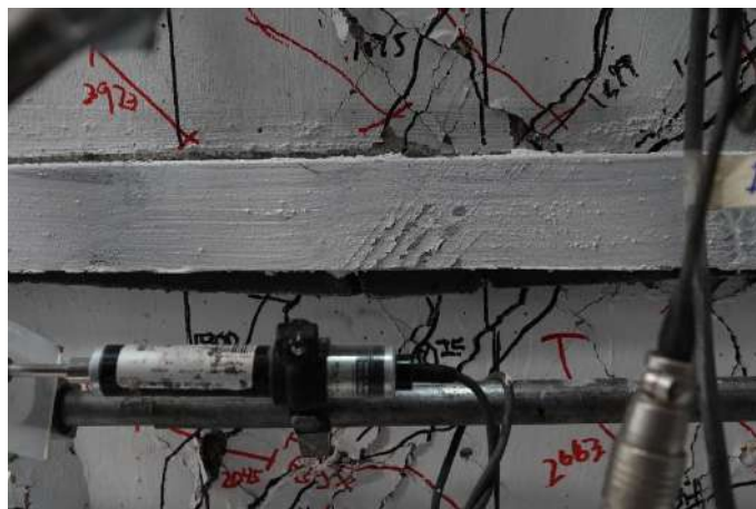
Fig. 3.3.128 Grout cara sur - Columna C-2 (Instituto de Ingeniería, 2021 - 2023)
