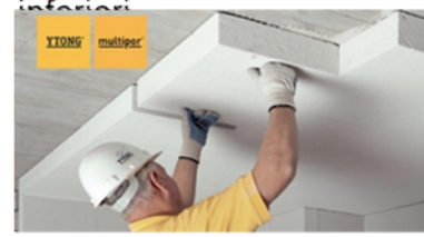
Isolamento da sotto
