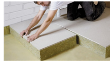
Isolamento da sopra
