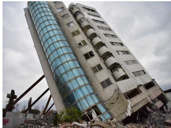
12-story Condominium 2018 Hualien EQ
