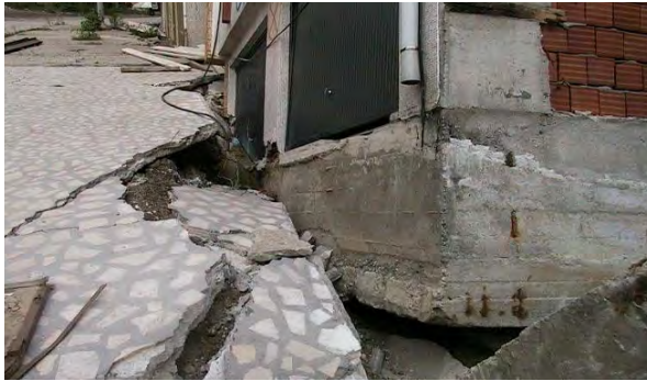
a) Hundimiento de un edificio.
