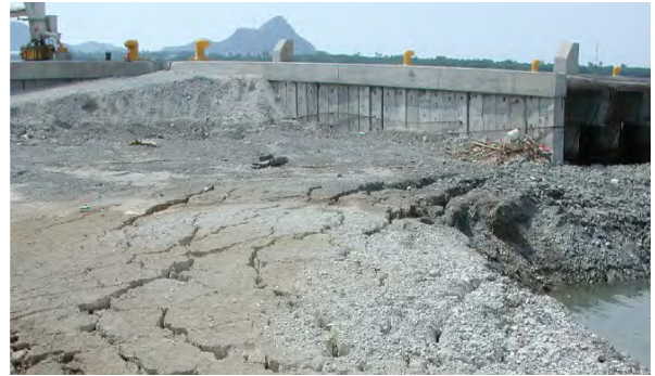
b) Desplazamiento lateral del suelo producido por licuación de arenas (véase las zonas de arena expulsada).
