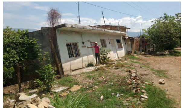
d) Construcción inclinada ubicada en el hombro de una ladera inestable.
