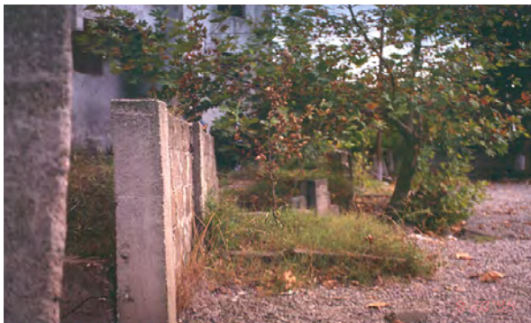
c) Desfase de una barda producto de movimiento del terreno adyacente a una falla superficial.
