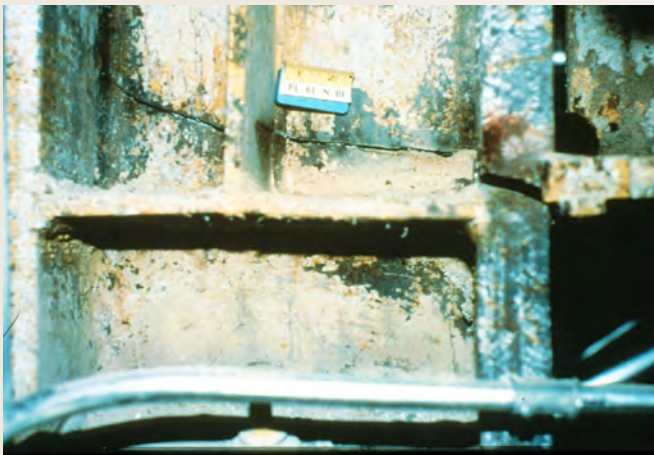
Figura 8.2.5.l Fractura de una unión viga-columna soldada durante el sismo de Northridge de 1994. La fractura se propagó desde la soldadura hacia la columna. Fuente: cortesía de Michael Engelhardt (2020).
