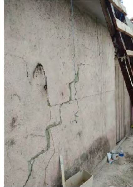
Figura 5.2 Deterioro de una estructura de mampostería simple. Fuente: cortesía del CENAPRED (2020b).
