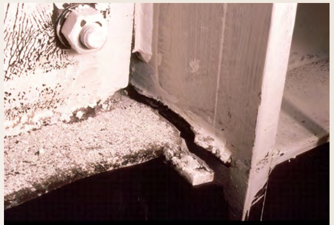
Figura 8.2.5.m Fractura en la soldadura en una conexión viga-columna. Fuente: cortesía de Michael Engelhardt (2020).
