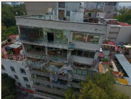
Figura 4.6 Ejemplos de golpeteo entre estructuras adyacentes durante los sismos de 2017 y 1985 en la Ciudad de México. Fuente: cortesía de Oriol Arnau (2017) y archivo personal de Sergio Alcocer (1985).
