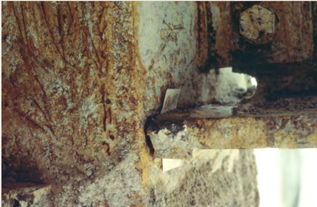
Figura 8.2.5.j Fractura de una conexión viga-columna en cajón soldada producida por el sismo de Northridge de 1994. Nótese la tarjeta personal a través de la soldadura fracturada. Fuente: cortesía de Michael Engelhardt (2020).
