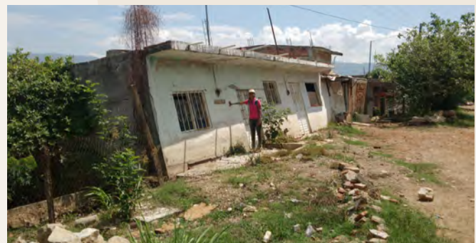
Figura 10.18 Ejemplos de manifestaciones superficiales de un deslizamiento de ladera: a) escarpes (escalones) en el hombro o parte alta del talud, b) inclinación de un poste, c) humedad inusual en el terreno. Fuente: cortesía de Irasema Alcántara (2020).
