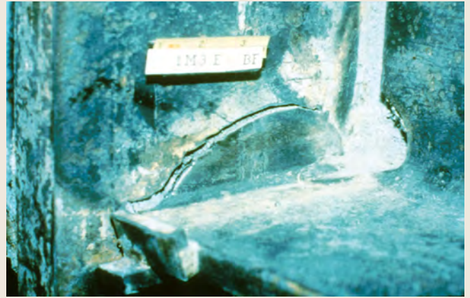
Figura 8.2.5.k Conexión viga-columna soldada que falló tras el sismo de Northridge de 1994. La grieta inició cerca de la raíz de la soldadura y se propagó dentro del patín de la columna. La fractura emergió del patín de la columna por arriba de la soldadura. Nótese la extracción de parte del patín de la columna. Fuente: cortesía de Michael Engelhardt (2020).
