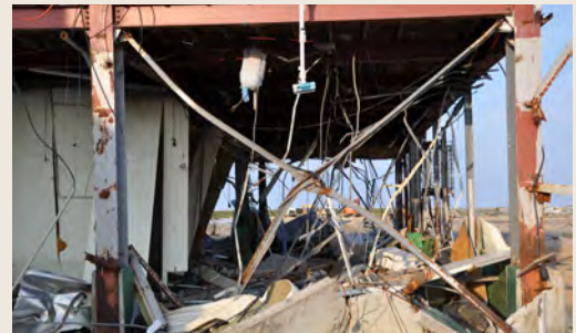
Figura 8.2.2.b Pandeo general por flexión en elementos de contraventeo. Fuente: http://learningfromearthquakes.org/2011-03-11-tohoku-japan/images/2011_03_11_tohoku_japan/photos/DSC_1257.jpg
