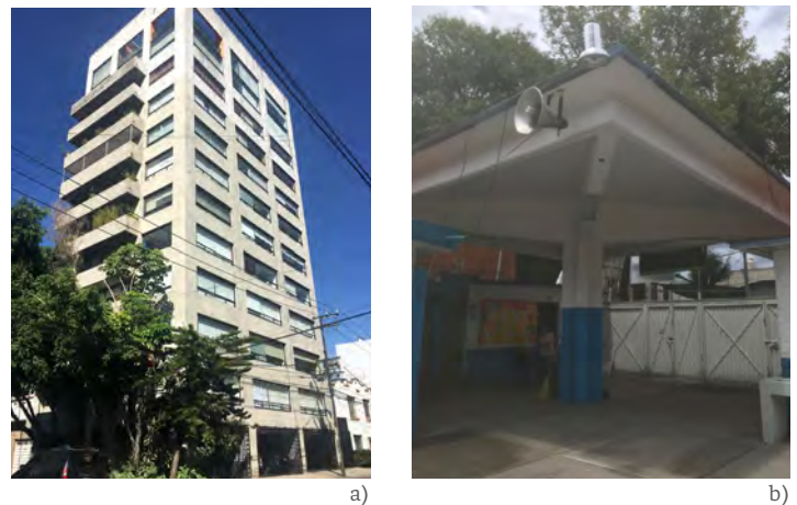
Figura 4.4 Ejemplos de estructuras con distintos niveles de redundancia: a) edificio a base de marcos de concreto; b) estructura en forma de péndulo invertido. Fuente: archivo personal de Sergio Alcocer (2019) y cortesía del INIFED (2019).
