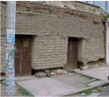
Figura 5.1 Deterioro de muros de adobe. Fuente: archivo personal de Sergio Alcocer (1999).
