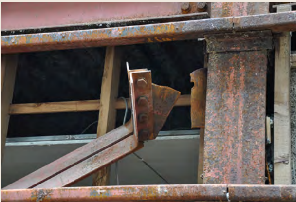
Figura 8.2.1.b Falla en placa de contraventeo por flujo plástico en la sección neta. Fuente: http://learningfromearthquakes.org/2011-03-11-tohoku-japan/images/2011_03_11_tohoku_japan/photos/DSC_0010.jpg
