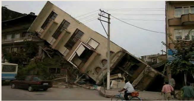
Figura 10.2 Ejemplo de falla rotacional generalizada. Fuente: archivo personal de Sergio Alcocer (1999).
