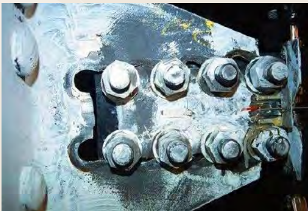
Figura 8.2.1.c Falla por tensión y cortante combinados en placa de conexión. Fuente: https://m2ukblog.wordpress.com/2016/05/28/block-shear-failure-in-tension-members/
