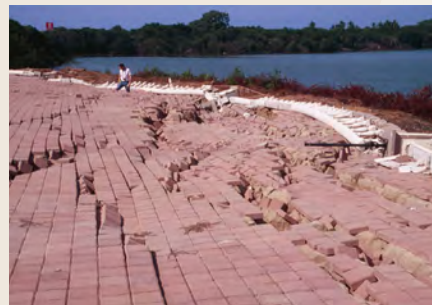
Figura 10.11.b Daño en patio de contenedores de un puerto producto de licuación. Fuente: cortesía de José Luis Rangel (2020).
