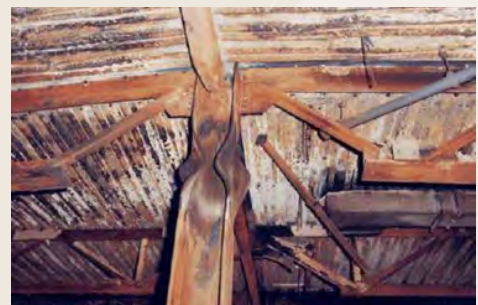
Figura 8.2.2.c Pandeo local de la sección (patines). Fuente: Wang et al. (2014).
