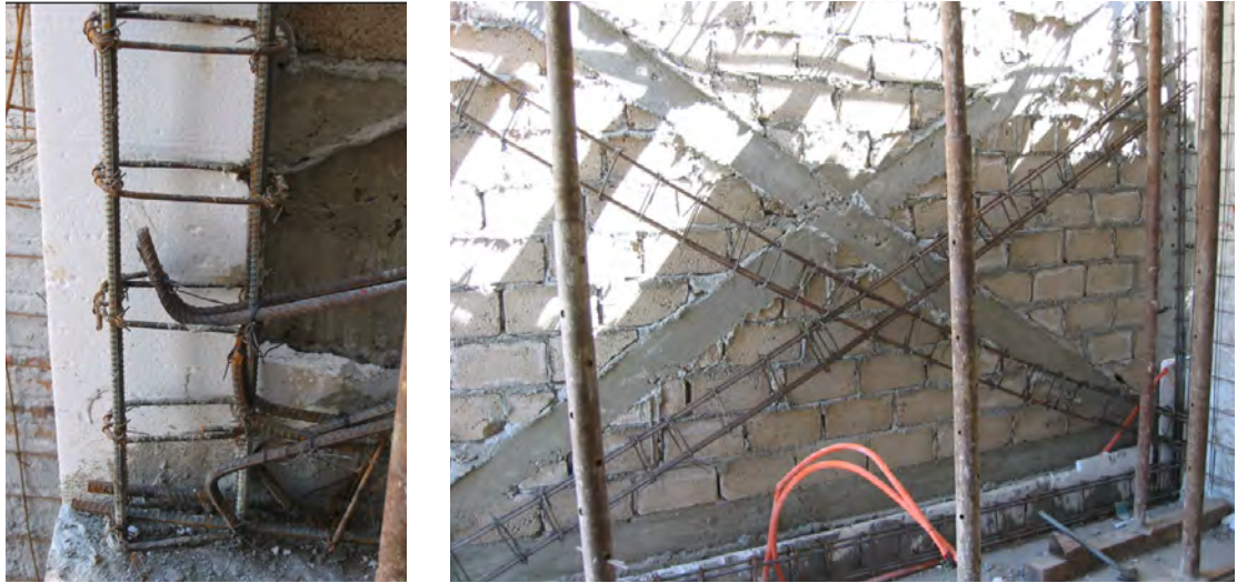
Figura 7.3 Insuficiente longitud de anclaje del refuerzo de las "cruces de San Andrés". Fuente: archivo personal de Sergio Alcocer (1997).
