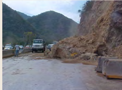
Figura 10.16 Ejemplos de deslizamientos de taludes artificiales. Fuente: cortesía de José Luis Rangel (2020).
