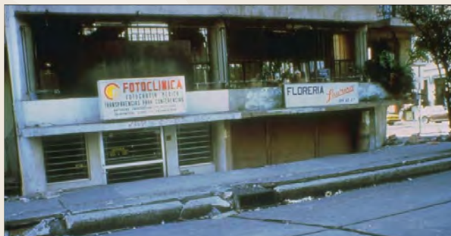
Figura 10.4 Ejemplo de falla por punzonamiento bajo la cimentación. Fuente: archivo personal de Sergio Alcocer (1985).
