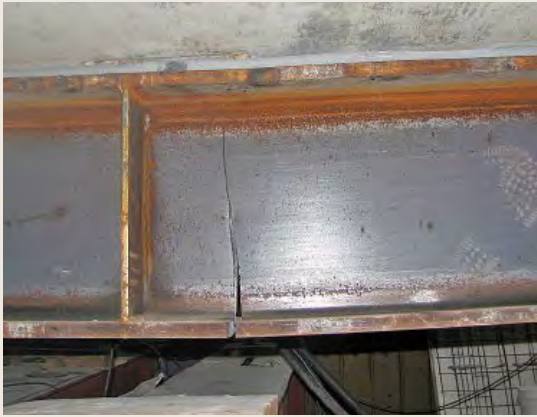
Figura 8.2.3.a Rotura del patín y alma tras la fluencia de la viga. Fuente: Gioncu y Anastasiadis (2014).
