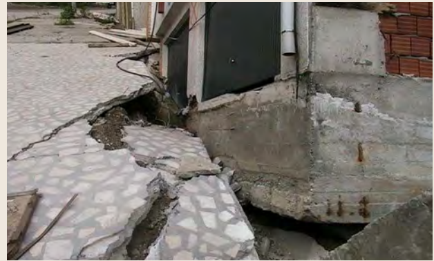
Figura 10.6 Ejemplo de falla local. Fuente: archivo personal de Sergio Alcocer (1999).
