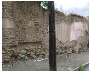
Figura 5.1 Deterioro de muros de adobe. Fuente: archivo personal de Sergio Alcocer (1999).
