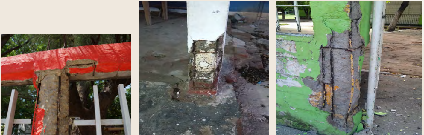
Figura 5.3 Deterioro de estructuras de concreto reforzado y de mampostería confinada. Fuente: cortesía del INIFED (2019).
