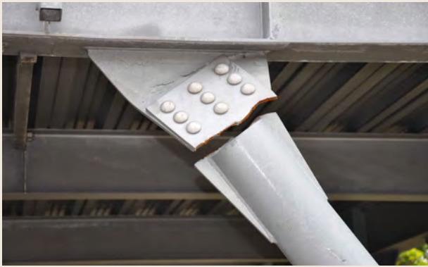
Figura 8.2.1.a Falla en placa de contraventeo por flujo plástico en la sección total. Fuente: http://learningfromearthquakes.org/2011-03-11-tohoku-japan/images/2011_03_11_tohoku_japan/photos/PGarage-Gusset-Fracture.jpg
