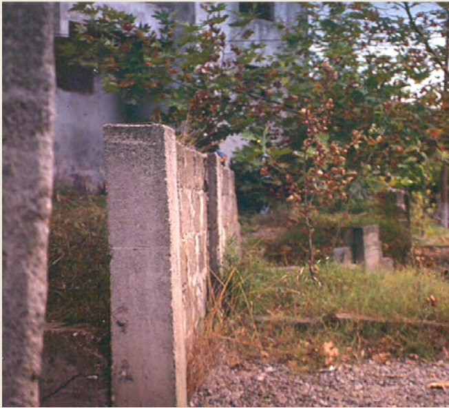
Figura 10.20 Desplazamiento horizontal (desfase) de una barda a lo largo de la falla geológica superficial tras el sismo de Izmit, Turquía, del 17 de agosto de 1999. Fuente: archivo personal de Sergio Alcocer (1999).
