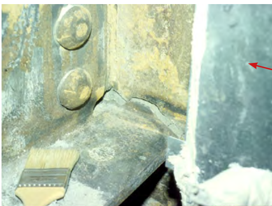
Figura 8.2.5.i Fractura de conexiones viga-columna soldadas a raíz del sismo de Northridge de 1994. Fuente: cortesía de Michael Engelhardt (2020).
