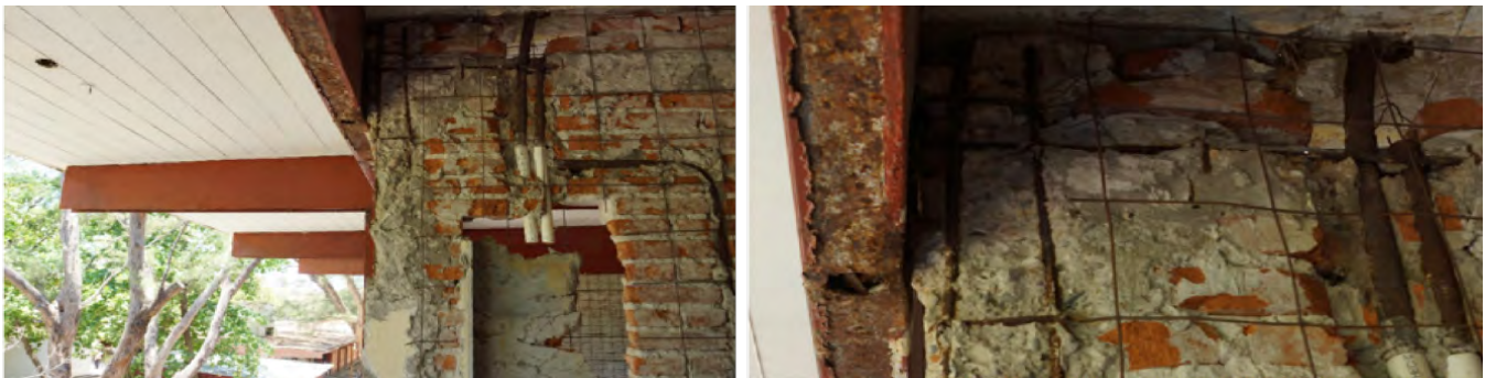
Figura 5.4 Deterioro de estructuras de acero estructural. Fuente: cortesía del INIFED (2019).
