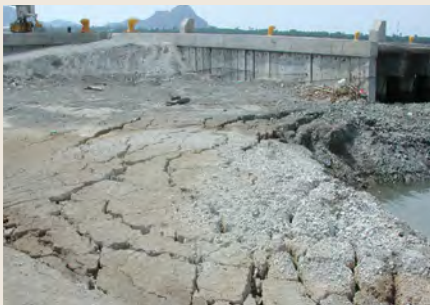
Figura 10.11.a Daño en patio de contenedores de un puerto producto de licuación. Fuente: cortesía de José Luis Rangel (2020).
