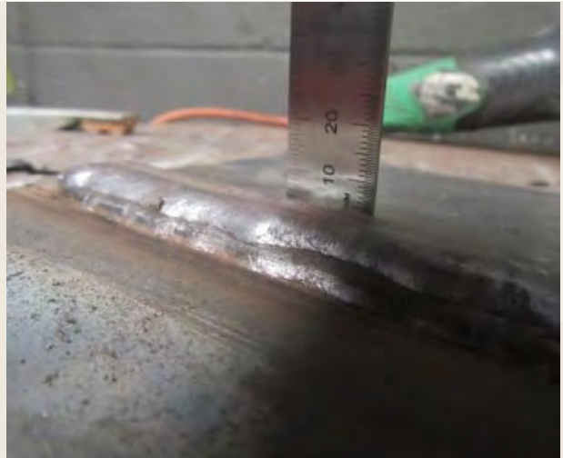
Figura 8.2.5.h Exceso de refuerzo en junta a tope. Fuente: https://technoweld.com.au/2019/11/13/the-most-common-welding-defects-causes-and-remedies/
