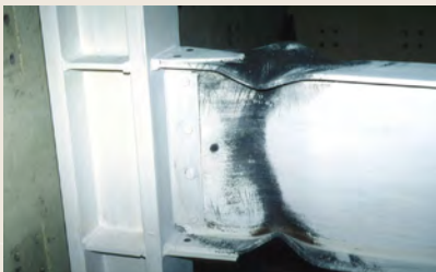
Figura 8.2.3.b Fallas por pandeo local de los patines y el alma tras la formación de las articulaciones plásticas de las vigas. Fuente: cortesía de Michael Engelhardt (2020).
