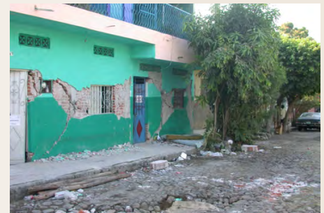
Figura 10.11.c Vivienda dañada en zona que experimentó licuación de arenas. Fuente: cortesía de José Luis Rangel (2020).
