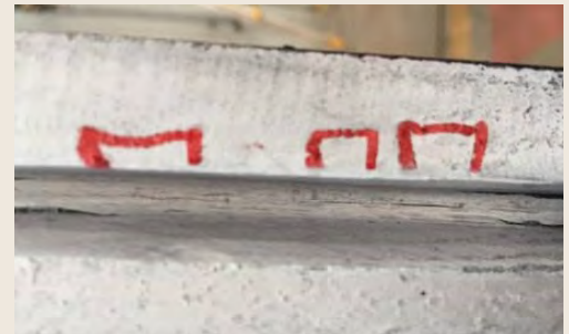
Figura 8.2.5.c Falta de fusión en la raíz en junta de doble bisel. Fuente: https://technoweld.com.au/2019/11/13/the-most-common-welding-defects-causes-and-remedies/
