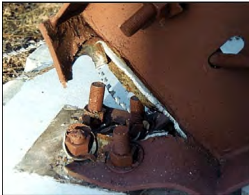
Figura 8.2.4.a Falla por cortante en la placa base de una columna. Fuente: Marshall, Gilvary y Kestner (2012).
