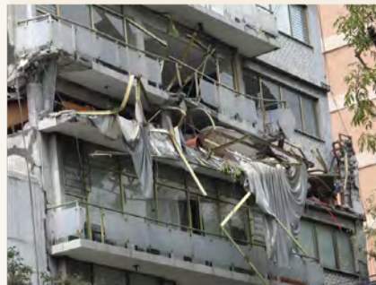
Figura 4.6 Ejemplos de golpeteo entre estructuras adyacentes durante los sismos de 2017 y 1985 en la Ciudad de México. Fuente: cortesía de Oriol Arnau (2017) y archivo personal de Sergio Alcocer (1985).
