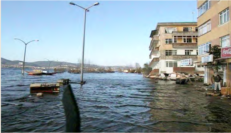
Figura 10.10 Entrada del mar en zona costera que sufrió desplazamiento lateral por licuación. Fuente: archivo personal de Sergio Alcocer (1999).
