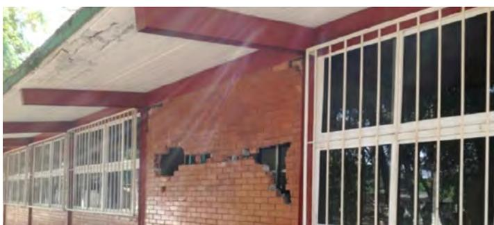
Figura 3.8 Comportamiento observado en la mayoría de las vigas de acero en escuelas de México. Fuente: cortesía del INIFED (2019).
