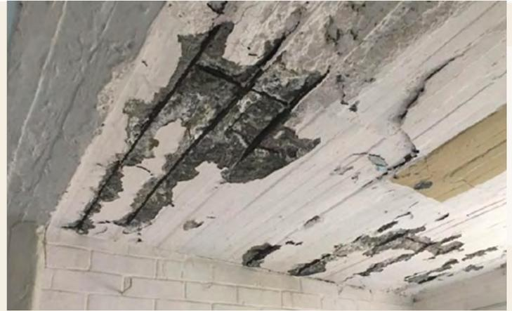
**Figura 3.28** Corrosión del acero de refuerzo vertical en bardas perimetrales.
