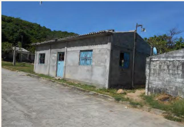
Figura 5.2a Estructuras de mampostería confinada sin daño.
