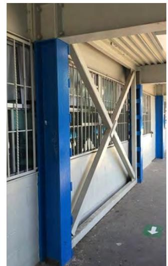
Figura 3.17 Conexiones excéntricas viga-columna en estructuras metálicas.
