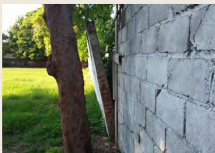
Figura 5.4i Barda visiblemente inclinada.
