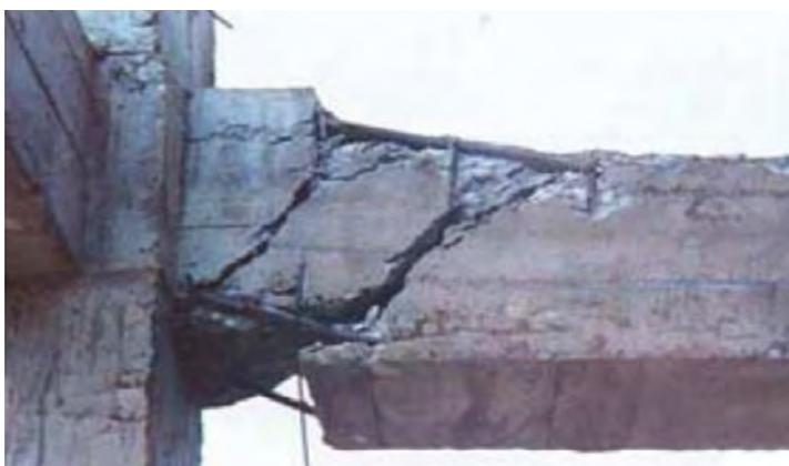
Figura 3.7 Falla por tensión diagonal pura en viga de concreto. Fuente: Instituto Valenciano de la Edificación (2019).
