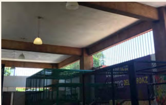
Figura 5.2b Estructura de concreto reforzado sin daño en columnas y vigas: sólo se evidencia agrietamiento y desprendimiento del mortero de acabado a lo largo de la junta vertical entre columnas y muros exteriores.
