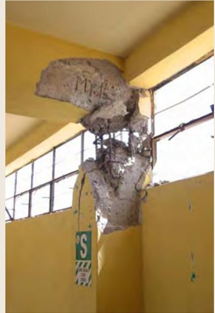
Figura 5.5g Ejemplos de falla de columnas por tensión diagonal por el efecto de "columna corta".
