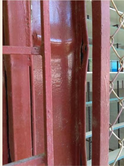
**Figura 3.14** Falla por aplastamiento, con pandeo local de placas y fractura de soldaduras en columnas de acero por el efecto de "columna corta".
