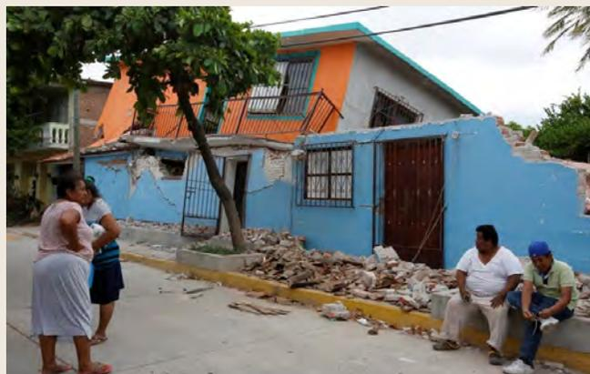
Figura 5.4b Colapso total de un edificio de mampostería.
