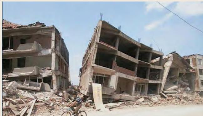
Figura 5.5b Colapsos totales de marcos de concreto reforzado.
