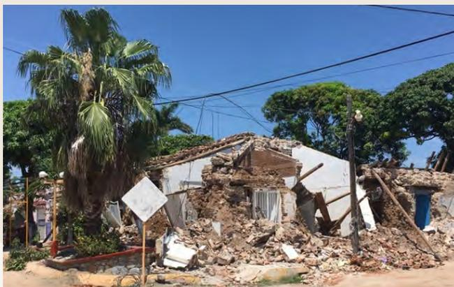
Figura 5.4a Colapso total de una edificación de adobe.
