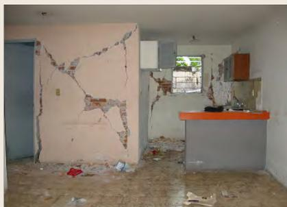
Figura 5.5i Agrietamiento por tensión diagonal en un edificio de mampostería mal confinada.
