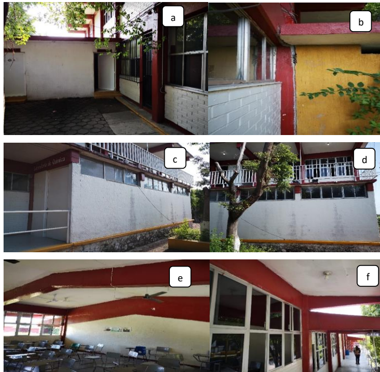
Figura 4.8 - Vista los edificios inspeccionados del plantel CBTIS No. 136.
